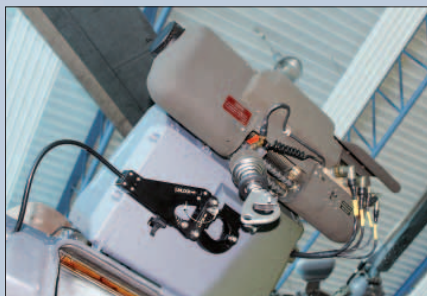
Jeřáb HS-29900-59 na novém nosníku The HS-29900-59 hoist with new pylon
