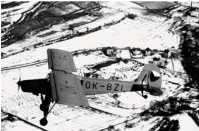
Letadlo K-65 „Čáp“ s motorem ARGUS As10C o výkonu 176 kW
